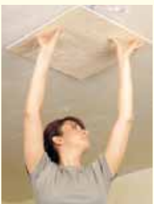
Deckenplatte müheles ankleben
