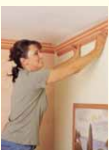
Zierprofil einfach ankleben
