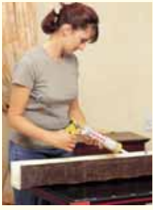
Balken DECOSA- Universalkleber in Kartusche auftragen
