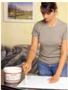
Deckenplatten DECOSA-Styroporkleber auftragen
