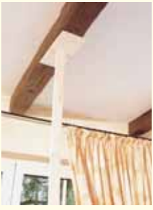
Balken mit Holzlatzen zum Klebertrocknen abstützen
