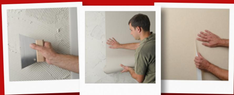
Kleber flächendeckend auf die Wand auftragen. Dämmmaterial auf Länge zuschneiden und vollflächig in das Kleberbett einlegen. Mit der Gummirolle fest andrücken. Stöße und Eckbereiche sorgfältig verspachteln. Nach dem Trocknen kann der gewünschte Oberbelag nach Herstellerangaben verarbeitet werden.
